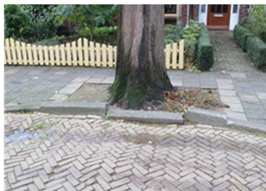
Wortelopdruk bij onvoldoende ondergrondse groeiruimte
