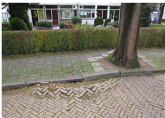
Wortelopdruk bij onvoldoende ondergrondse groeiruimte
