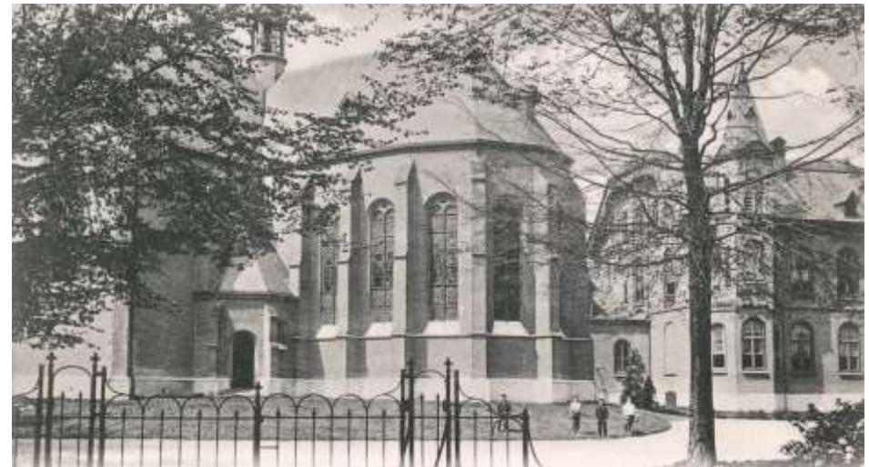
Ansichtkaart met het oorspronkelijke smeedijzeren toegangshek aan de Herenweg, ca. 1900. Regionaal Historisch Centrum Leiden, beeldbank, pbk 4625.
