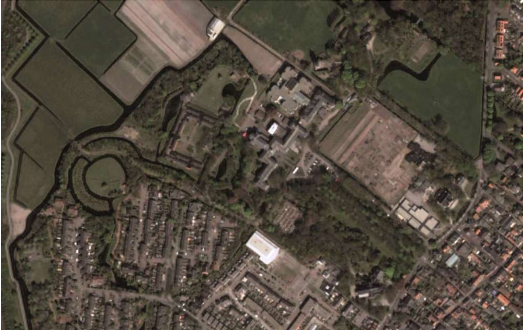
Luchtfoto 2003, Google Earth. Het uit 1976 daterende Mariënhaven voor de sloop in 2005.
