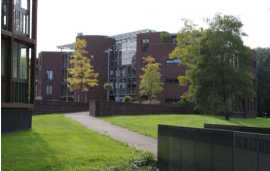
Brug vanaf Park Klinkenberg richting het slingerbos met een pad van betonplaten. Rond Park Klinkenberg staan diverse solitaire bomen in het gazon, ook op het plein van het appartementencomplex
