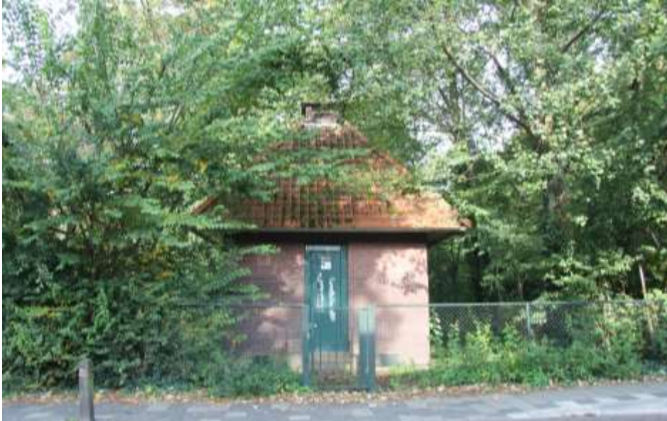
Het elektriciteitshuisje gezien vanaf de Herenweg
