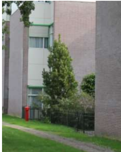
Metalen sierhekwerk bij de hofjes tussen de vleugels
