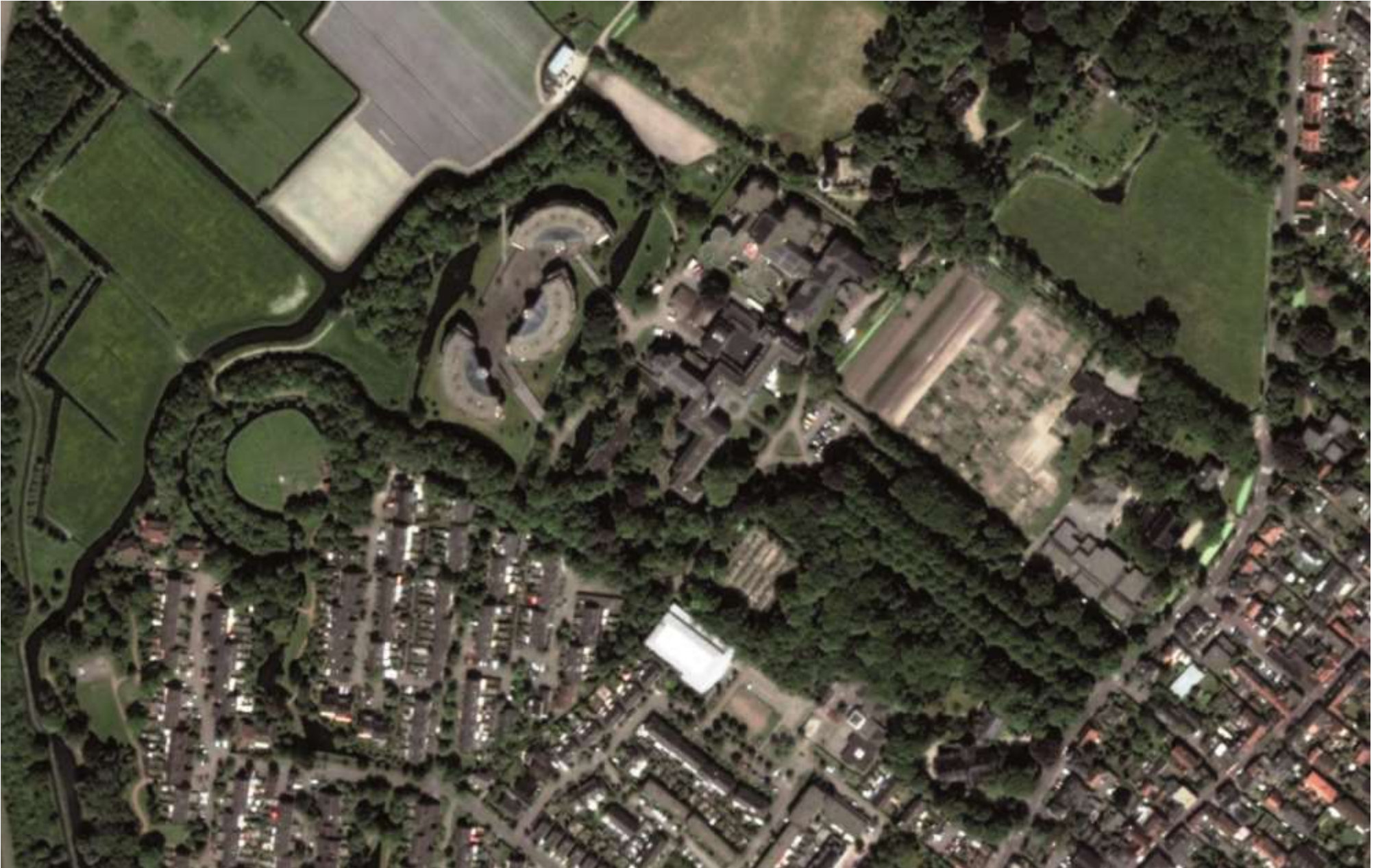
Luchtfoto 2012, Google Earth. Park Klinkenberg na de gereedkoming. Goed zichtbaar de tijdelijke bebouwing die ten koste ging van de parkaanleg in landschapsstijl ten westen van de kapel.
