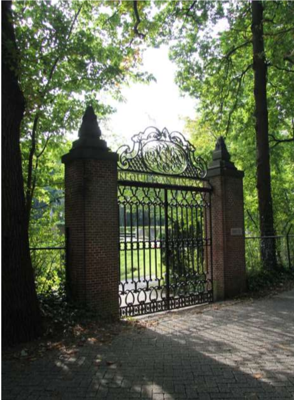
Het historisch smeedijzeren hek aan de noordzijde van de begraafplaats
