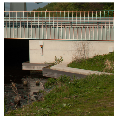
▲ Voorbeeld van een eenvoudig spijlen hekwerk
