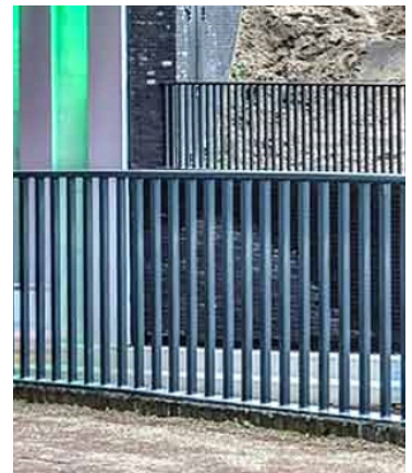
▲ Voorbeeld van een eenvoudig spijlen hekwerk
