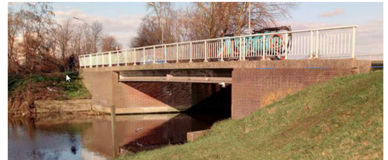
▲ De gevel van de Noordwijkerbrug
