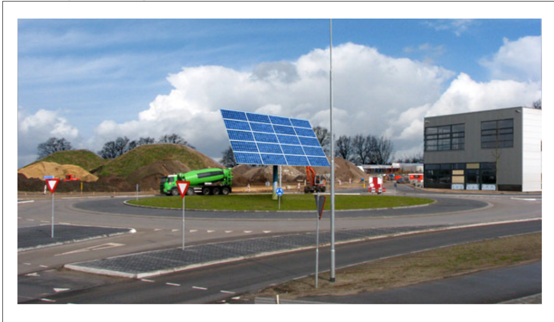
Afbeelding VI.5. PV-panelen in rotonde
