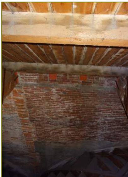
Uitbreiding kapel afleesbaar in metselwerk
