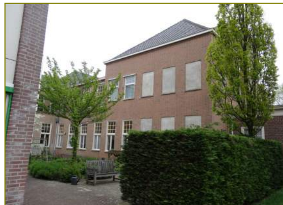
Achtergevel bouwdeel G, links deels origineel, rechts daterend uit 1996
