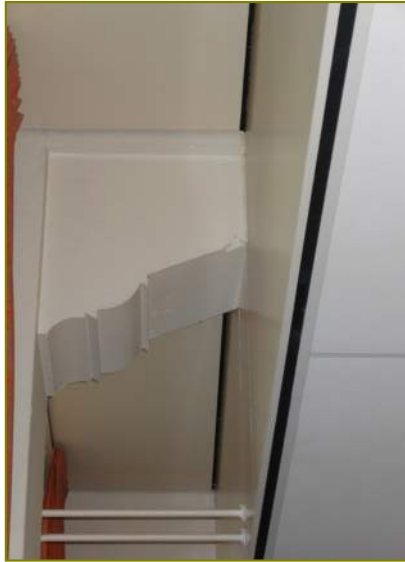
Console onder kapelvloer
