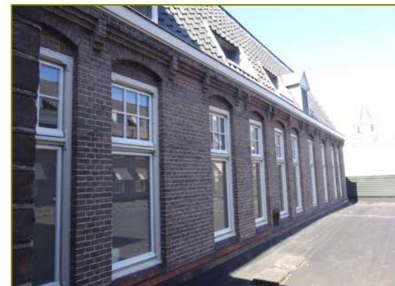
Voorgevel eerste verdieping dienstgebouw
