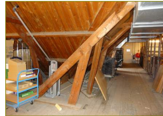
Krepele stijl op slof van verbeterd Hollandspant
