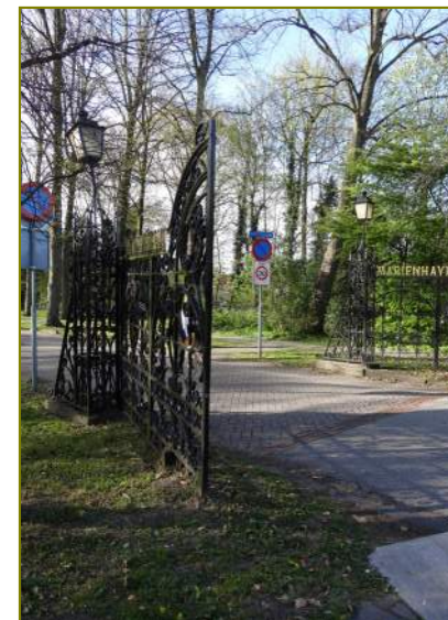
Smeedijzeren hekpoort en gemetselde baluster (rechts)
