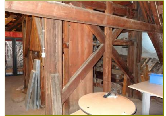
Constructie daktoren en gewichtkoker uurwerk
