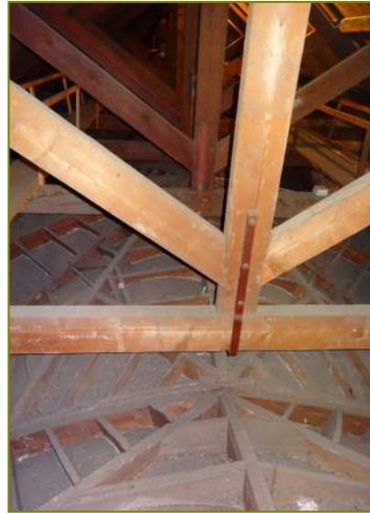
Hangspant en koepelgewelf
