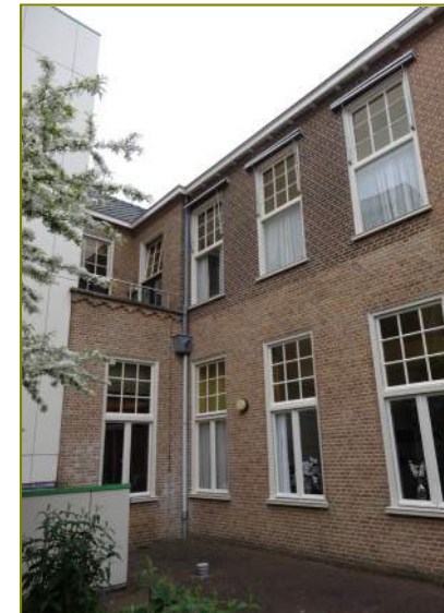
Aansluiting achtergevel bouwdeel G op doorloop
