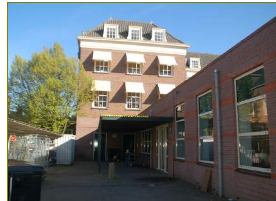
Achtergevel bouwdeel C2
