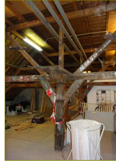
Standvink bouwdeel A
