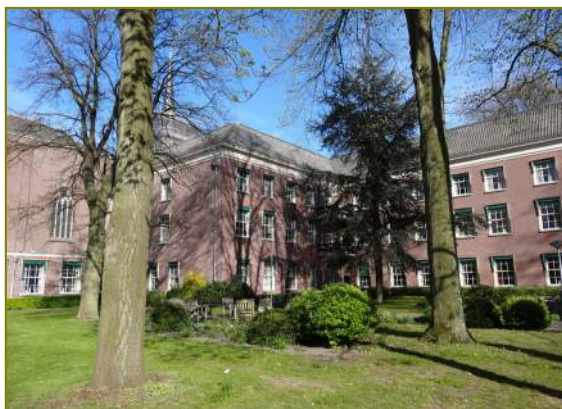
Achterevels bouwdeel A en B1
