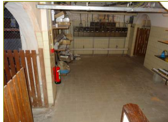
Boogdoorgangen en tegelafwerkingen
