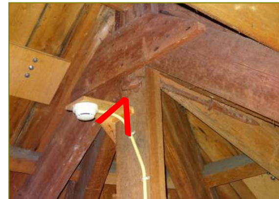
Spieankers kruising makelaar en hoekkepers
