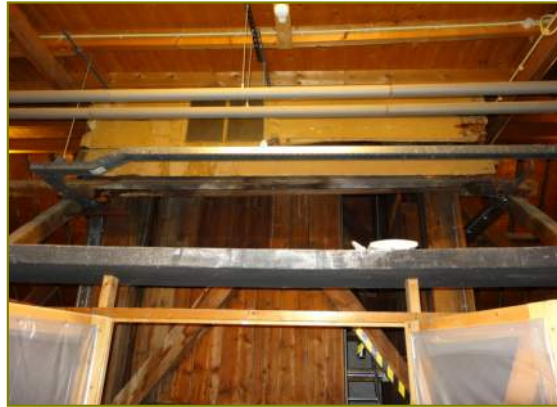
Dakkapel op voormalig binnendakvlak
