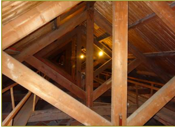
Hangspanten dakconstructie kapel
