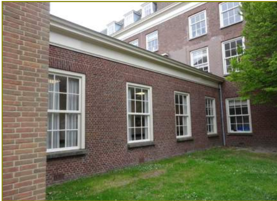
Achterzijde bouwdeel H2
