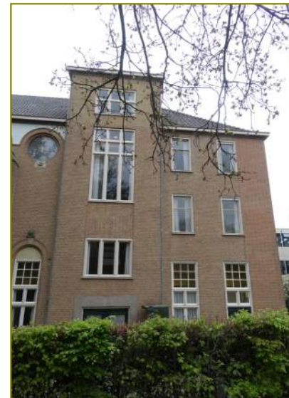
Trappenhuis rechter zijgevel
