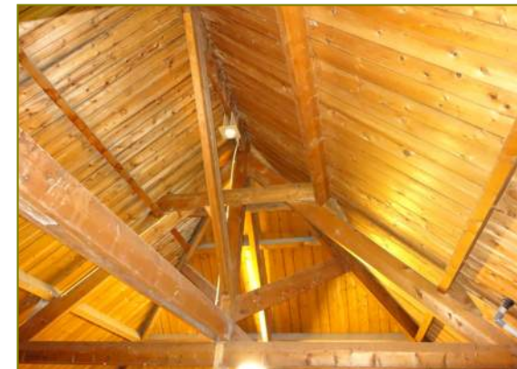
Dubbele trekplaten verbeterd Hollandspant
