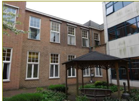
Achtergevel bouwdeel G - bouwdeel H1 (deels)
