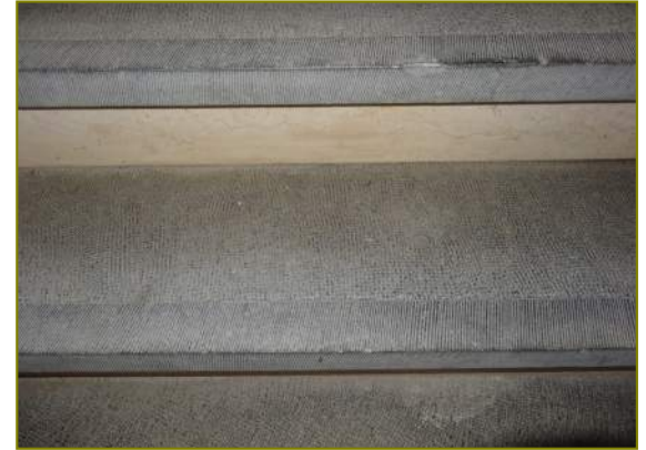
Detail fijnwerk en bouharderwerk in natuurstenen traptreden
