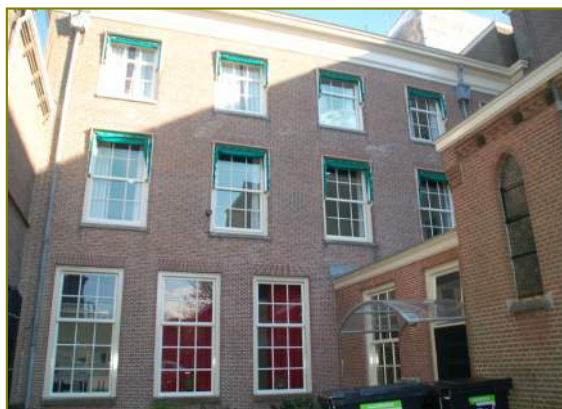
Achtergevel bouwdeel A
