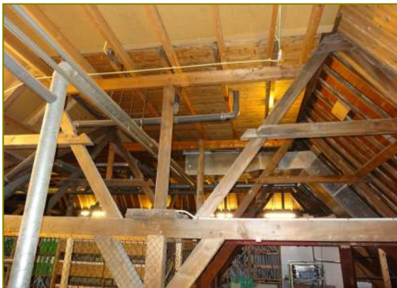
Plat dak boven voormalige zaggoot bouwhistorische opname
