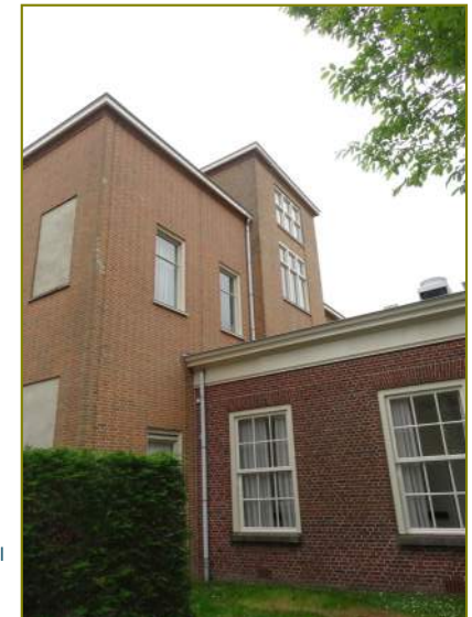
Achterzijde linker zijgevel
