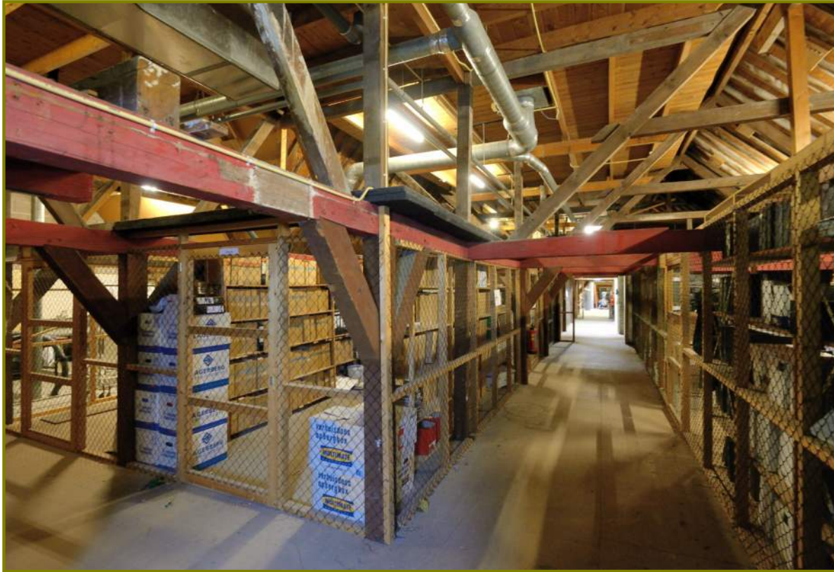
Kapconstructies bouwdeel A (Afbeelding: Mariënhaven Warmond BV)
