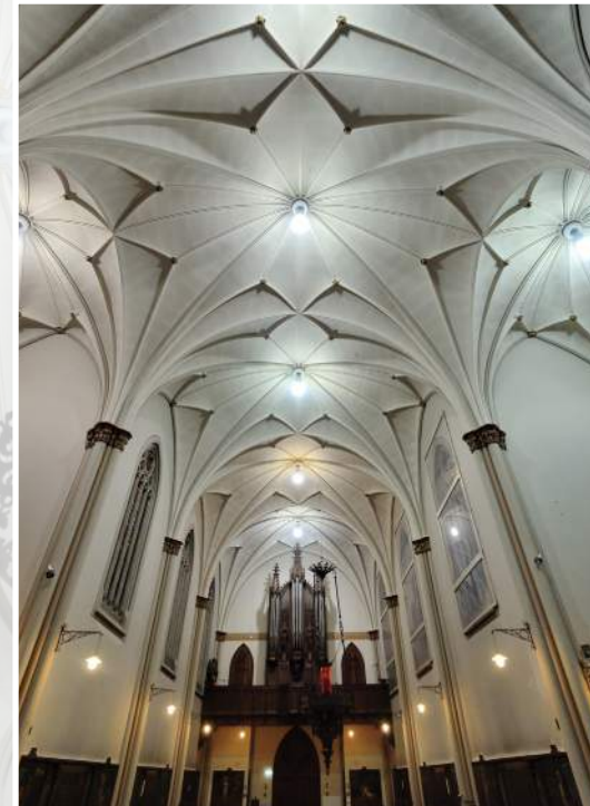
Waaiergewelven (Afbeelding: Mariënhaven Warmond BV)
