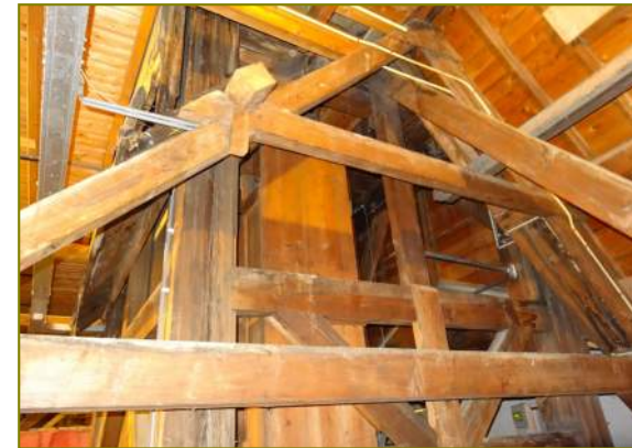
Torenconstructie tussen kapconstructie
