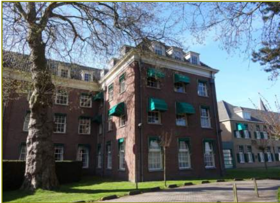
Voorgevel bouwdeel C2
