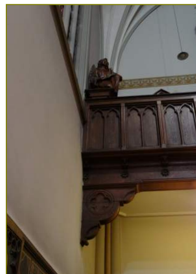
Omtimmerde console en draagbalken orgelgalerij
