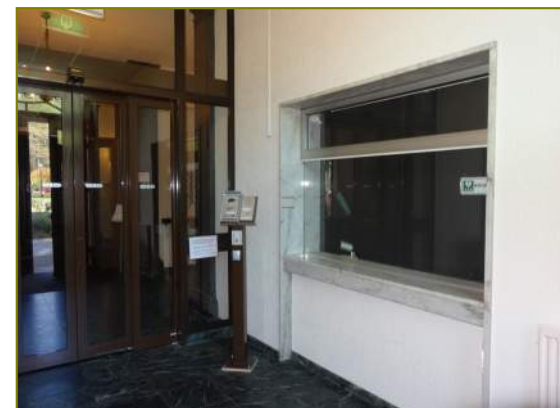
Centrale entree, gericht naar voorgevel
