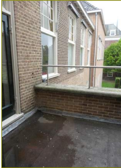
Balkon ter plaatse van doorloop naar bouwdeel H1
