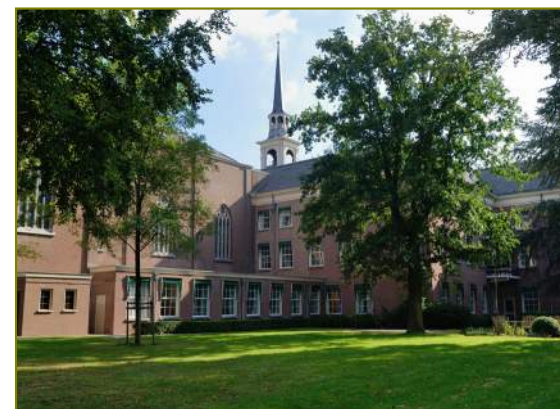
Achtergevel bouwdeel A
