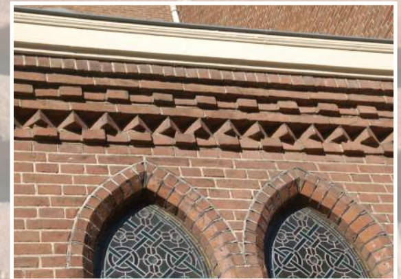
Blok- en muizenantennes in metselwerk
