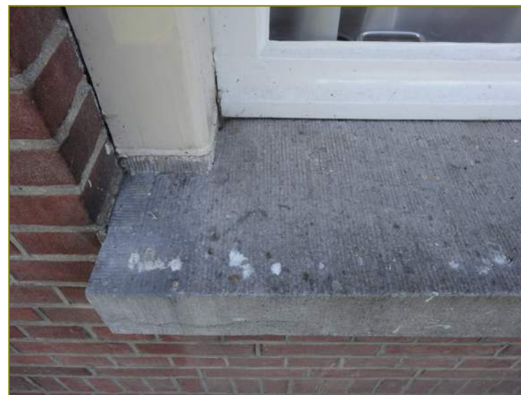
Detail natuurstenen waterslag met kussen en frijnslag
