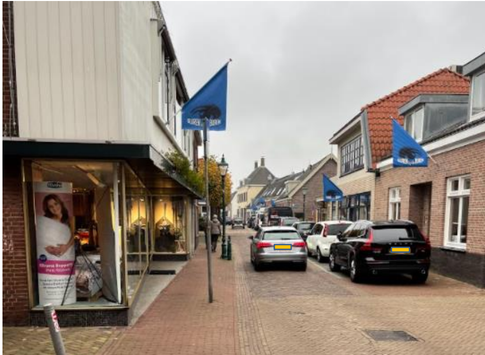
Figuur 19: Dorpstraat in Warmond, veel ruimte ingericht voor autoverkeer of -parkeren
