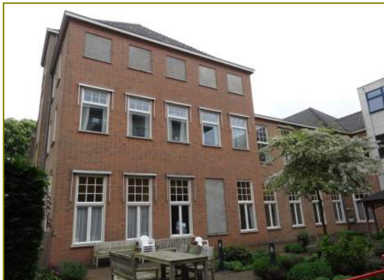
Achtergevel bouwdeel G uit 1996
