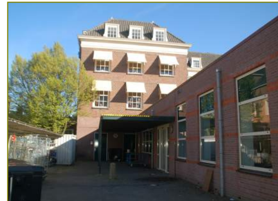
Achtergevel bouwdeel C2
