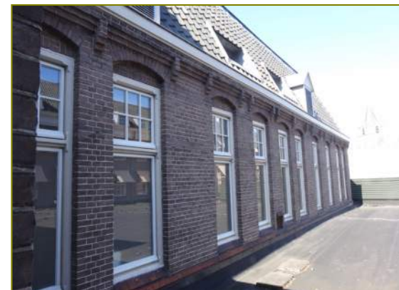
Voorgevel eerste verdieping dienstgebouw
