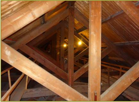
Hangspanten dakconstructie kapel
