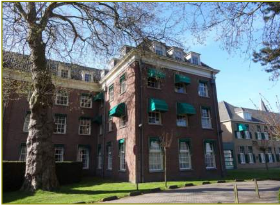
Voorgevel bouwdeel C2
