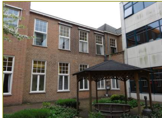
Achtergevel bouwdeel G - bouwdeel H1 (deels)
