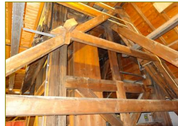
Torenconstructie tussen kapconstructie
