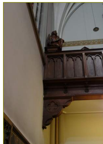
Omtimmerde console en draagbalken orgelgalerij
