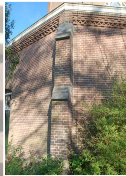
Steunbeer op hoek kapellenkrans
