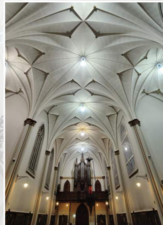
Waaiergewelven (Afbeelding: Mariënhaven Warmond BV)
