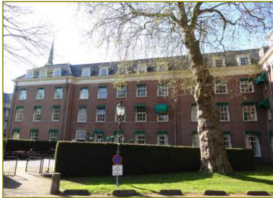
Voorgevels bouwdeel B2
