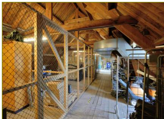
Dakconstructies bouwdeel G
