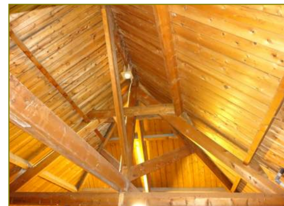
Dubbele trekplaten verbeterd Hollands pant
