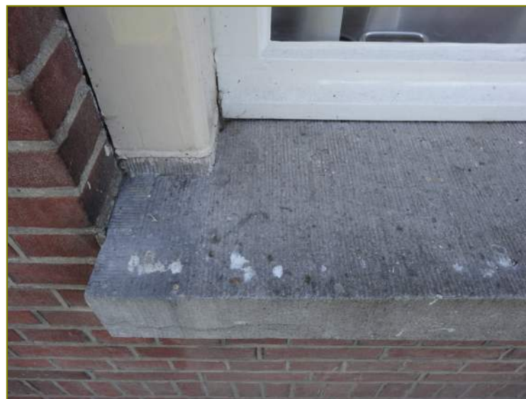
Detail natuurstenen waterslag met kussen en frijnslag
