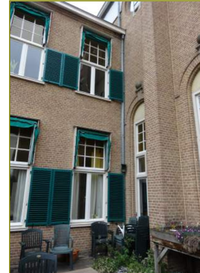
Aansluiting voorgevel op kapel bouwdeel G
