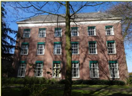
Linker zijgevel bouwdeel C1
