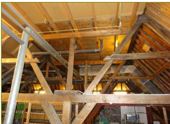
Plat dak boven voormalige zakgoot bouwhistorische opname
