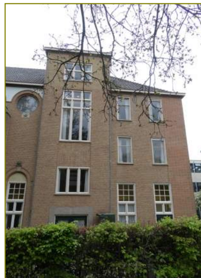
Trappenhuis rechter zijgevel
