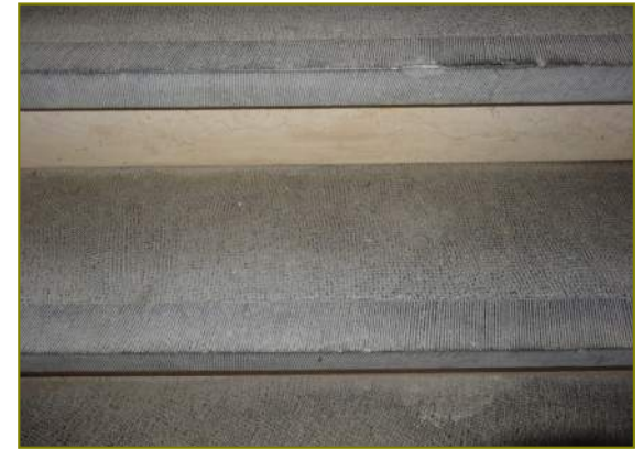
Detail frijnwerk en bouhardeerwerk in natuurstenen traptreden
