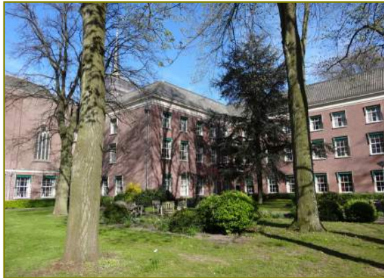
Achtergevels bouwdeel A en B1
