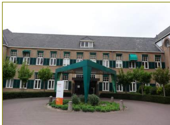
Entree bouwdeel G
