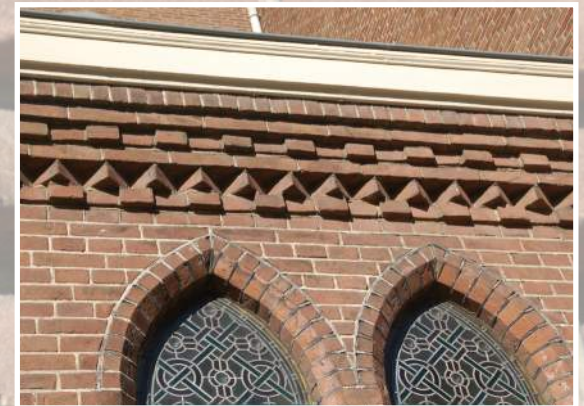
Blok- en muizentanden in metselwerk
