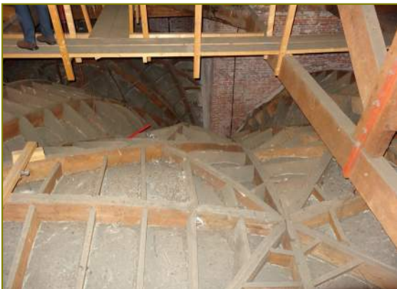
Overgang schip en dwarsschip
