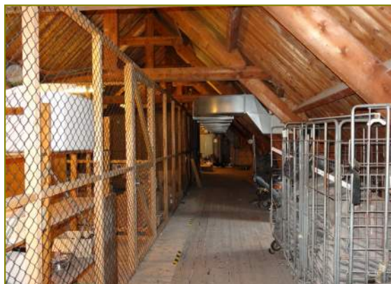
Dakconstructies bouwdeel G
